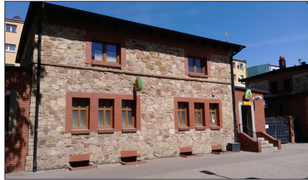
Ryc. 9. Budynek kolonii Ficinus zbudowany z nietypowego na Górnym Śląsku materiału – piaskowca (fot. A. Szweda).
