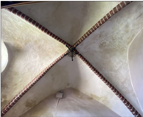
Ryc. 9. Kościół parafialny pw. św. Jadwigi Śląskiej, zachowane sklepienie gotyckie w kaplicy północnej; fot. autor
