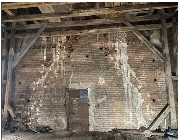
Ryc. 7. Kościół parafialny pw. św. Jadwigi Śląskiej, strych, zachodni szczyt kościoła z XIII w. i wieża; fot. autor
