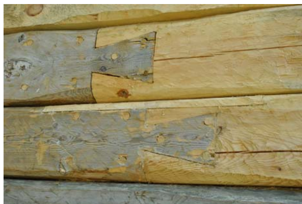
Ryc. 9. Widok połączeń ciesielskich materiału nowo budowanego z pierwotnym materiałem, 2015, fot. Ł. Gołda
