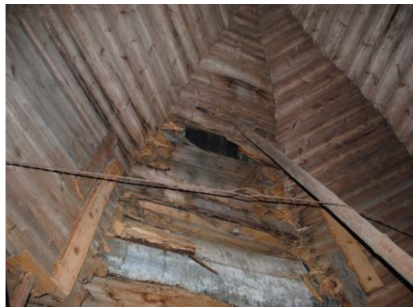
Ryc. 4. Fragment zniszczonego sklepienia kopuły nad sanktuarium, strona wschodnia, 2013, fot. Ł. Gołda Fig. 4. Fragment of the damaged ceiling dome over the sanctuary, the eastern side, 2013, photo by Ł. Gołda
