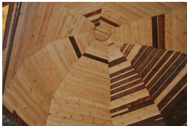
Ryc. 7. Widok wyremontowanej konstrukcji sklepienia nawy, 2015, fot. Ł. Gołda
