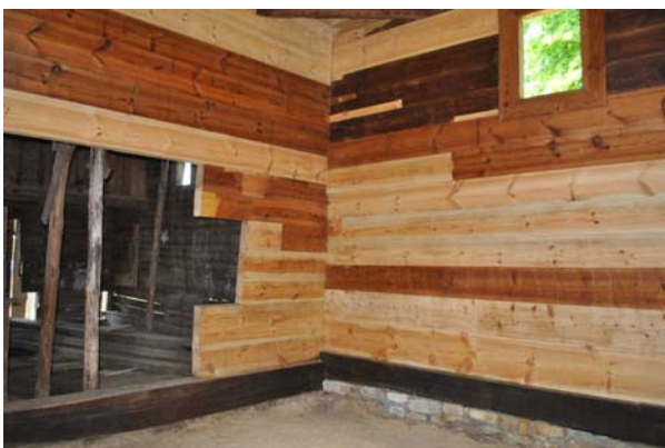
Ryc. 8. Widok wyremontowanej konstrukcji ściany zrębowej, 2015, fot. Ł. Gołda
