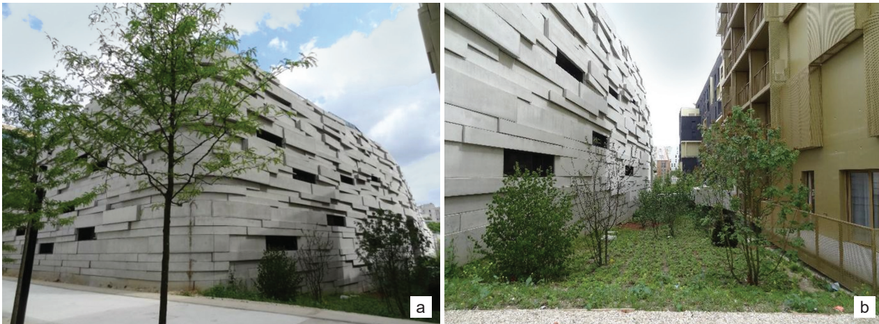
Il. 1. Le Groupe Scolaire des Sciences et de la Biodiversité Robert Doisneau, ZAC Trapèze, Boulogne-Billancourt (proj. Chartier Dalix): a) elewacja „żywej ściany” z wyprofilowanych płyt, które z czasem pokryje roślinność, b) zagospodarowanie terenu wokół „żywej ściany” (fot. M. Trojanowska)
