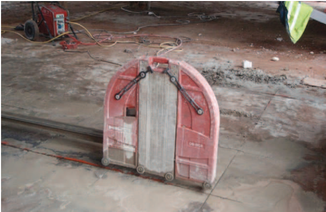
Rys. 12. Cięcie wyburzanej powierzchni stropu na elementy nadające się do ręcznego transportu
