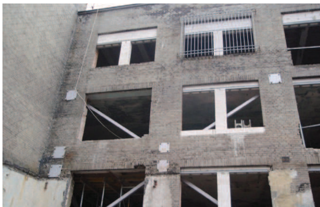
Rys. 9. Stężenia w kierunku podłużnym budynku w osiach zewnętrznych R,U i wewnętrznych S,T
