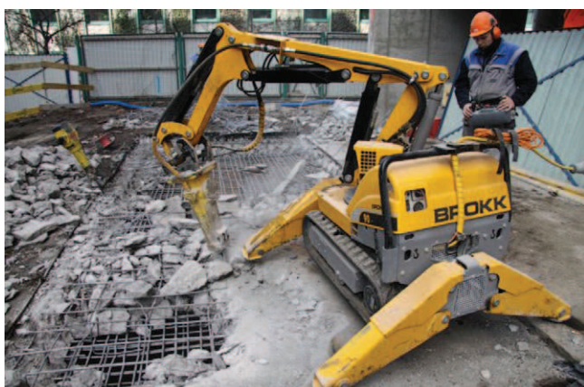
Rys. 11. Mechaniczne wyburzenie obszarów stropu z pozostawieniem prętów do zakotwienia
