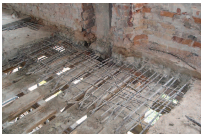
Rys. 11. Mechaniczne wyburzenie obszarów stropu z pozostawieniem prętów do zakotwienia
