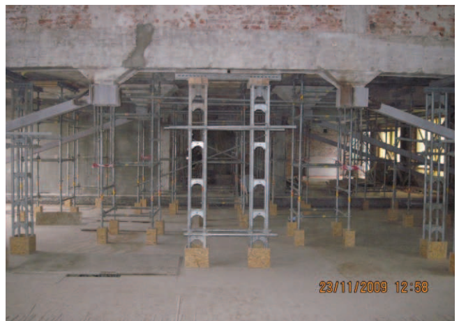
Rys. 13. Kolumny przejmujące obciążenia montażowe oraz obciążenia pionowe z wyższych pięter
