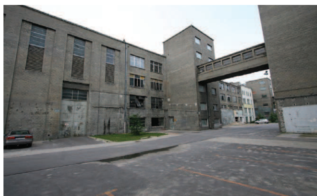
Rys. 1. Modernizowany budynek III etapu od strony podwórza
