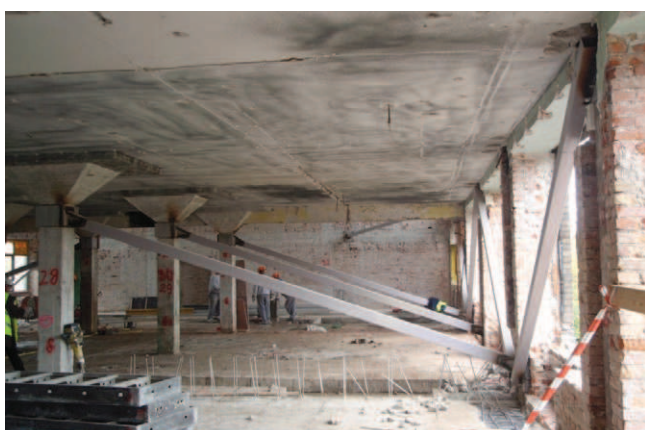
Rys. 10. Stężenia pionowe w kierunku poprzecznym remontowanego budynku
