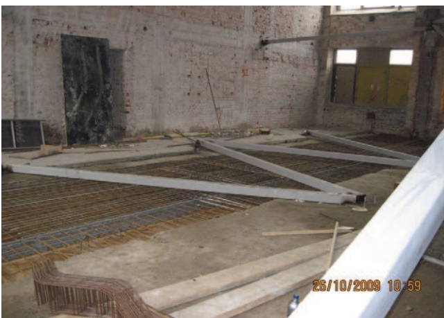
Rys. 14. Prace wyburzeniowe części 1. Widoczne stare zbrojenie stropowe łączone z nowym
