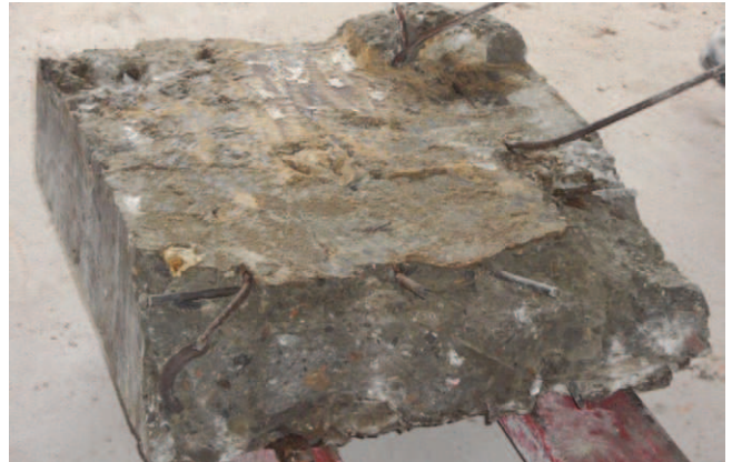
Rys. 12. Cięcie wyburzanej powierzchni stropu na elementy nadające się do ręcznego transportu
