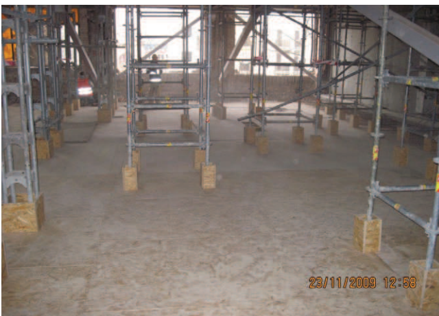
Rys. 13. Kolumny przejmujące obciążenia montażowe oraz obciążenia pionowe z wyższych pięter
