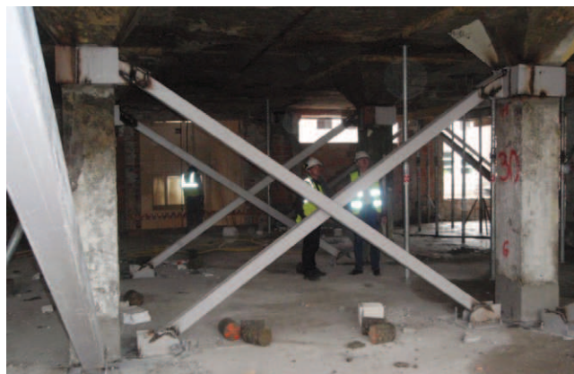
Rys. 9. Stężenia w kierunku podłużnym budynku w osiach zewnętrznych R,U i wewnętrznych S,T
