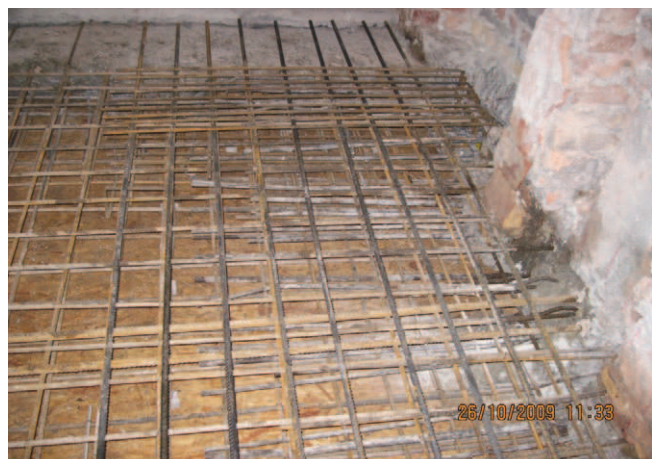
Rys. 14. Prace wyburzeniowe części 1. Widoczne stare zbrojenie stropowe łączone z nowym
