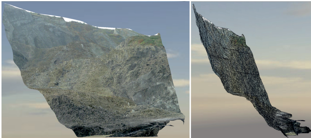
Rys. 7. Model fragmentu zbocza zbudowany na podstawie zdjęć wykonanych przez geologa w trakcie inspekcji terenowej. Na rysunku po prawej widoczny model trójkątowy powierzchni zbocza na którym wtórnie rozpięte zostały zdjęcia Fig. 7. Three-dimensional model of the slope built on the basis of images taken by the geologist during the inspection field. At right, visible the three-dimensional mesh model of the slope on which the images were restretched
