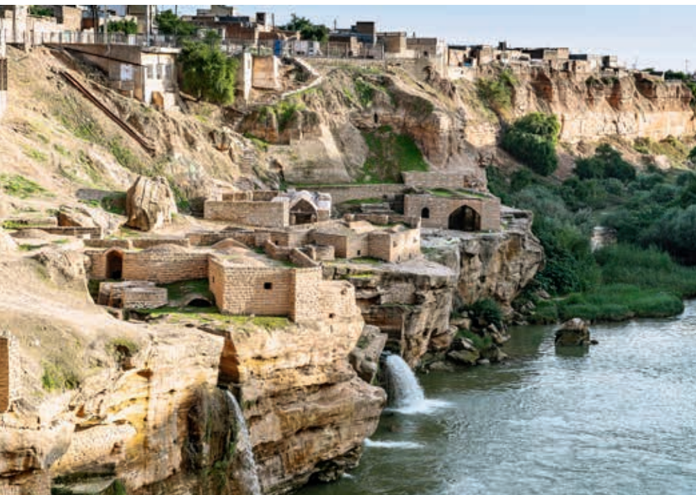
Historyczny system hydrauliczny w Shushtar
