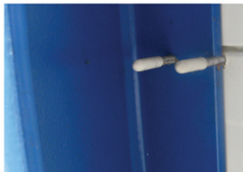
Fot. 7. Klimatyzator zawieszony na ścianie z płyt warstwowych w znaczny sposób obciąża punktowo okładzinę tych płyt
