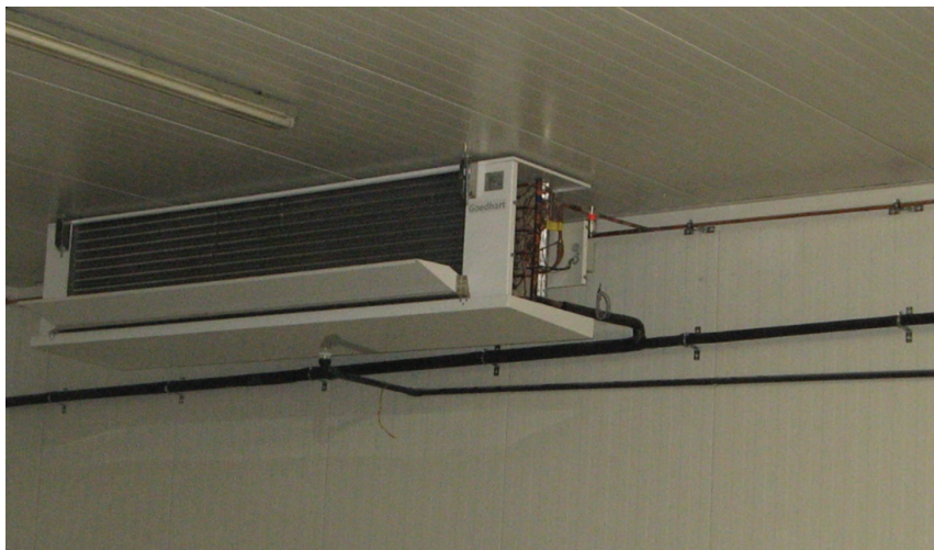
Fot. 7. Klimatyzator zawieszony na ścianie z płyt warstwowych w znaczny sposób obciąża punktowo okładzinę tych płyt
