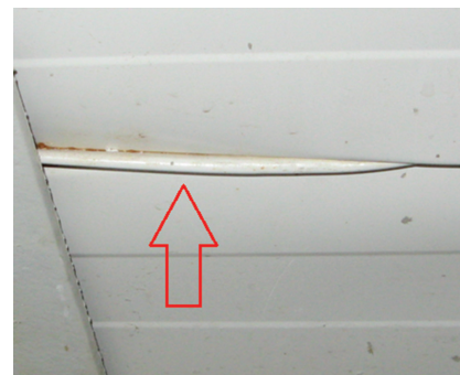
Fot. 5. Widok od strony wewnętrznej zdeformowanego zamka po mechanicznym uszkodzeniu płyty warstwowej. Widoczna rdza świadczy o uszkodzeniu powłok malarskich
