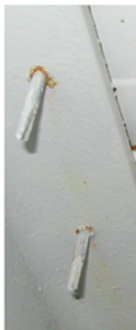
Fot. 8. Ocena łączników mechanicznych mocujących płyty warstwowe: a) korozja łączników; b) niewłaściwe mocowanie
