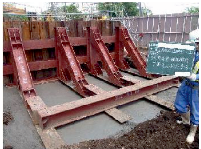
Fot. 9. Zbrojona ściana naporowa umożliwiająca przecisk rur [5]
