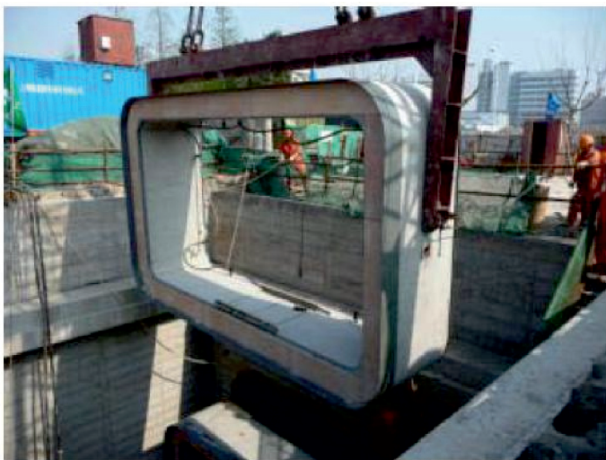
Fot. 5. Opuszczanie prefabrykatu żelbetowego na dno wykopu początkowego [1]
