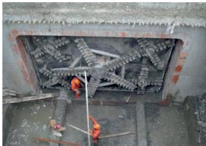
Fot. 6. Wyjście prostokątnego urządzenia tarczowego [1]
