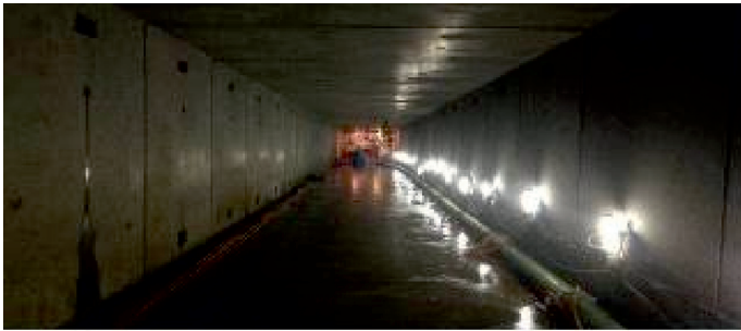
Fot. 10. Ukończone przejście podziemne [5]
