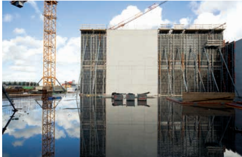
Deskowanie NOEtop na budowie magazynu na towary masowe w porcie Europort Rotterdam. Ściany boczne o wysokości do 13 m były betonowane w jednym etapie pracy, fot. NOE-Schaltechnik
