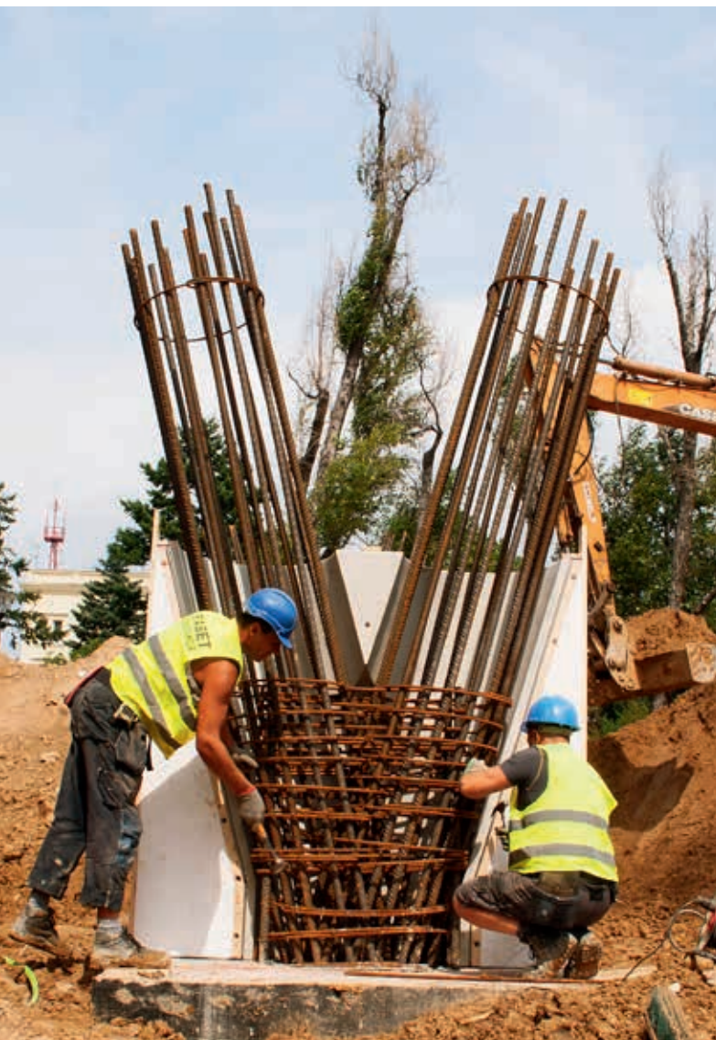
Szalunek specjalny PAL-X3M – system wykonany całkowicie z tworzywa sztucznego, pozwalający na idealne odwzorowanie zaprojektowanego kształtu, fot. Palisander Sp. z o.o.
