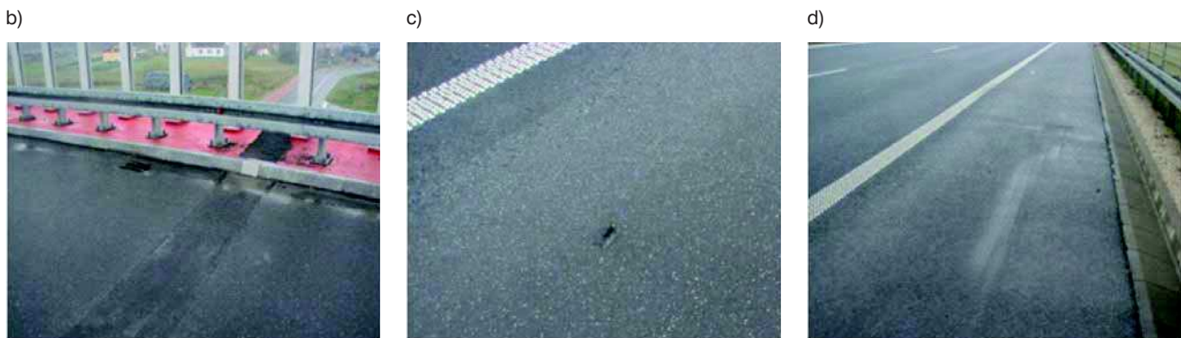
Rys. 2. Ilustracja: a) widok ogólny powierzchni pobocza na rozważanych odcinkach, b) dylatacja obiektu mostowego, c) ubytek w nawierzchni, d) nierówność podłużna w postaci „odcisku” opony samochodowej
