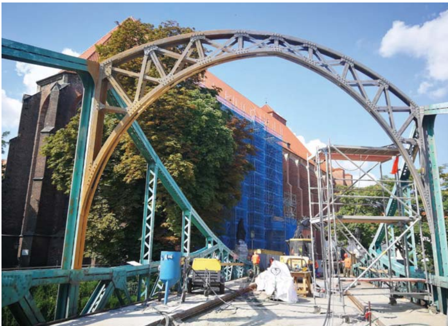
Fot. 4. Portal na podporze pośredniej poddawany zabezpieczeniu antykorozyjnemu
