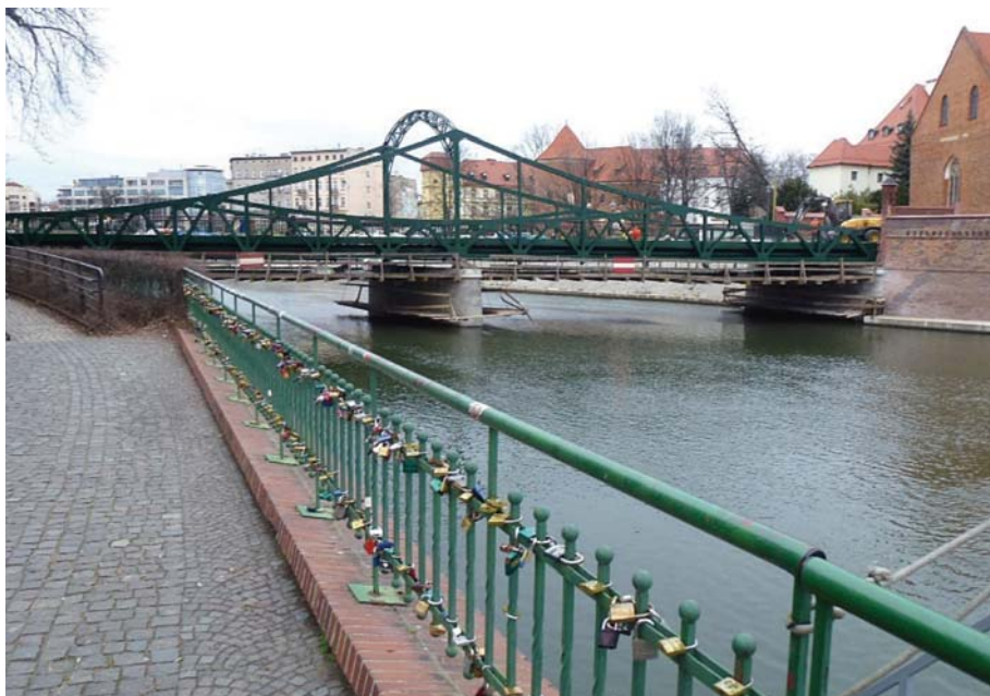
Fot. 5. Klódky na balustradach nabrzeża Odry w pobliżu mostu Tumskiego
