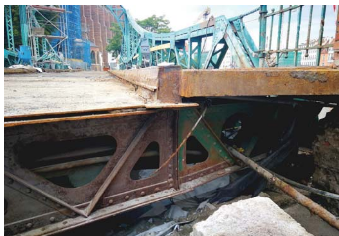
Fot. 3. Odślonięta poprzecznicę podporowa po demontażu ścianki zapleczej
