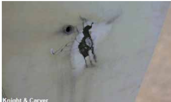
Fot. 2. Uszkodzenia kadłuba turbiny wiatrowej spowodowane uderzeniem pioruna [24]
