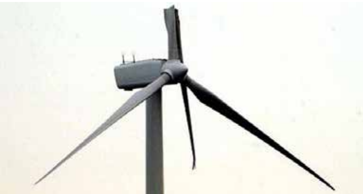
Fot. 1. Uszkodzone skrzydło (łopata) turbiny wiatrowej [24]
