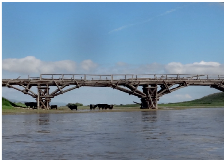
Fot. 2. Układ mostu trapezowo-zastrzałowego z rozpornicą w naturze (a) i w podręczniku (b); linie wpływu elementów mostu
