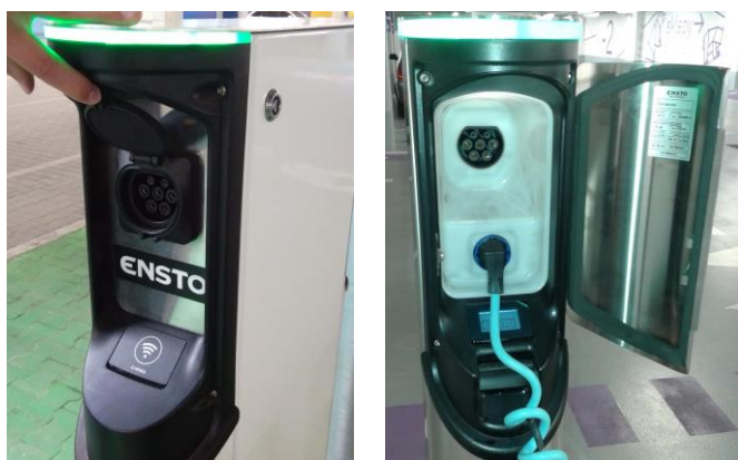
Rys. 6. Słupki ładowania z gniazdem Typ 2 i Schuko (po prawej)
