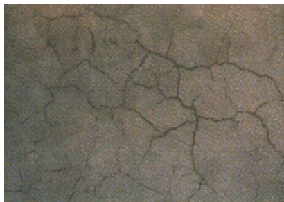
Rys. 2. Pęknięcia w betonie wywołane zjawiskiem reakcji alkalia–krzemionka [3]
