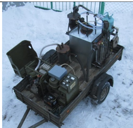
Рисунок 6. Общий вид экспериментальной газогенераторной установки с электростанцией AB-4-O/230-M1
