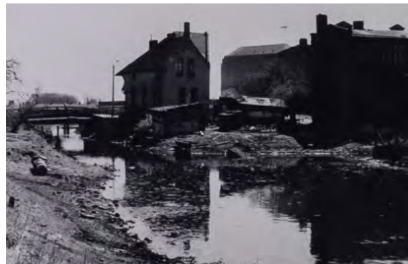
EC Gdańsk 2. Teren pod budowę
