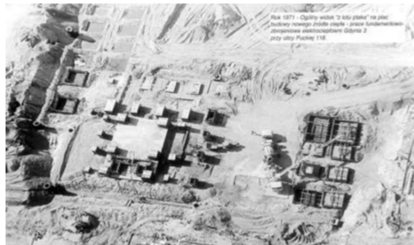
Budowa EC Gdynia 3. Plac budowy z lotu ptaka
