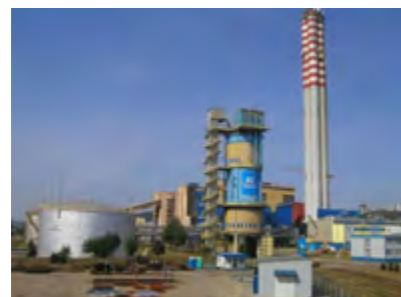
Budowa EC Gdynia 3. Lata 90. Widok ogólny
