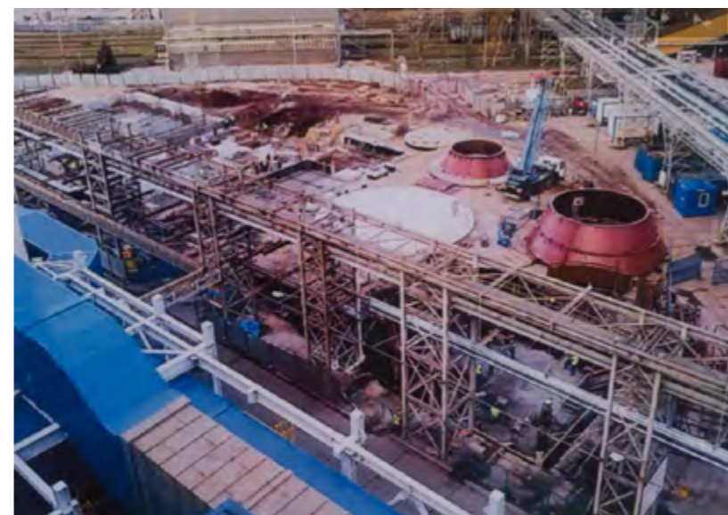
EC Gdańsk 2. Budowa IMOS
