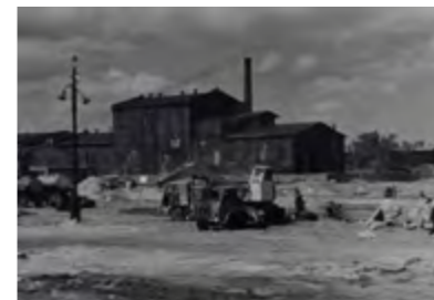
EC Gdańsk 2. Początek budowy
