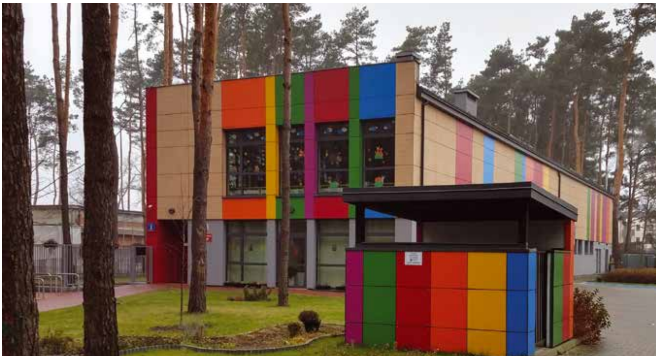
Fot. 2. Przedszkole przy ul. Antoniego Pankracego Łaguny w Warszawie, projekt: ARMA Studio Architektoniczne Robert Goździewicz
