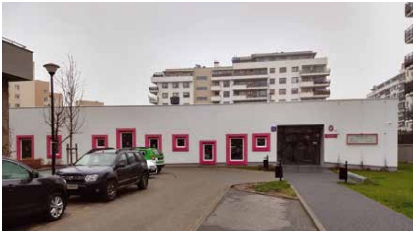
Fot. 3. Przedszkole przy ul. Rechniewskiego w Warszawie, projekt: FS&P ARCUS arch. Mariusz Ściśło
