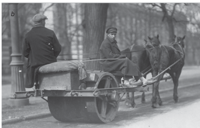
Rys. 6. Walce konne: a – z fabryki „M. Peterseima”, pocz. XX w.; b – w Warszawie (ze zbiorów Narodowego Archiwum Cyfrowego)
