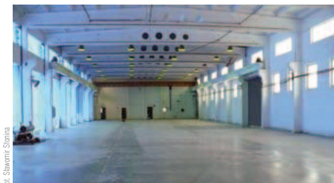
Fot. 3. Zabezpieczenie nowej posadzki przed szkodliwym wpływem czynników atmosferycznych
