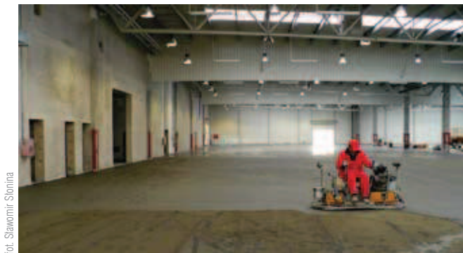
Fot. 1. Wykonywanie betonowej posadzki w technologii DST (Dry Shake Topping)
