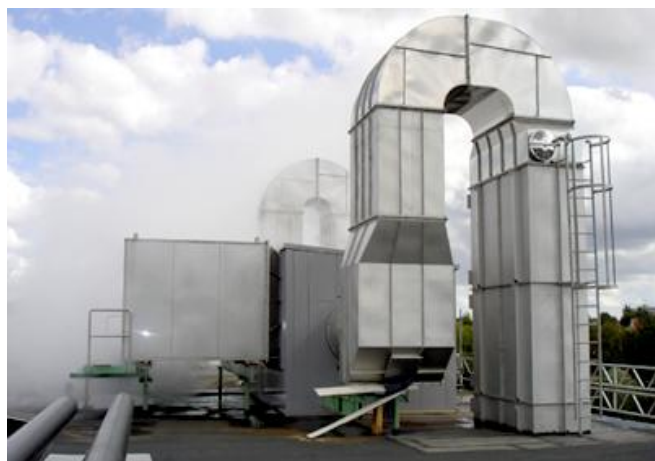
Rys. 5. Rekuperator ciepła w fabryce Dalum produkcji EV[9]
