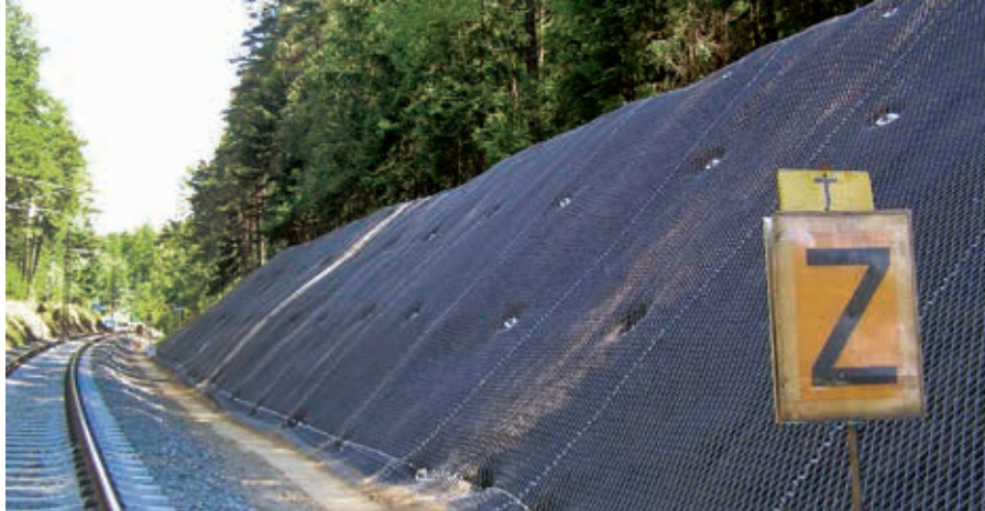
Oblicowanie skarpy systemem TECCO® firmy Geobrugg wzdłuż linii kolejowej Střibro – Pilzno w Czechach, fot. Geobrugg AG
