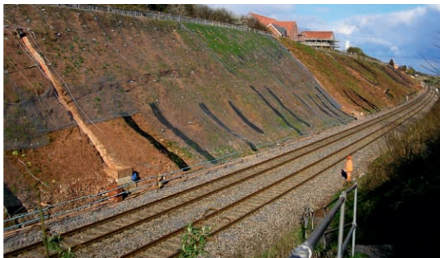
Instalacja systemu TECCO® firmy Geobrugg wzdłuż linii kolejowej Bristol – Taunton w miejscowości Flax Bourton w Wielkiej Brytanii, fot. Geobrugg AG
