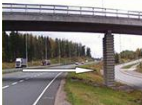
Rys. 4. Przykłady źródeł zagrożeń w otoczeniu drogi [12], [13].
