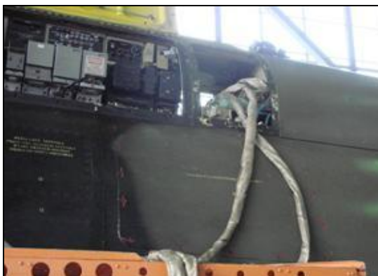
Rys. 15. Widok bloków i złącz elektrycznych kardanowego systemu nawigacji inercyjnej IKW-8 na samolocie Su-22 [14]
