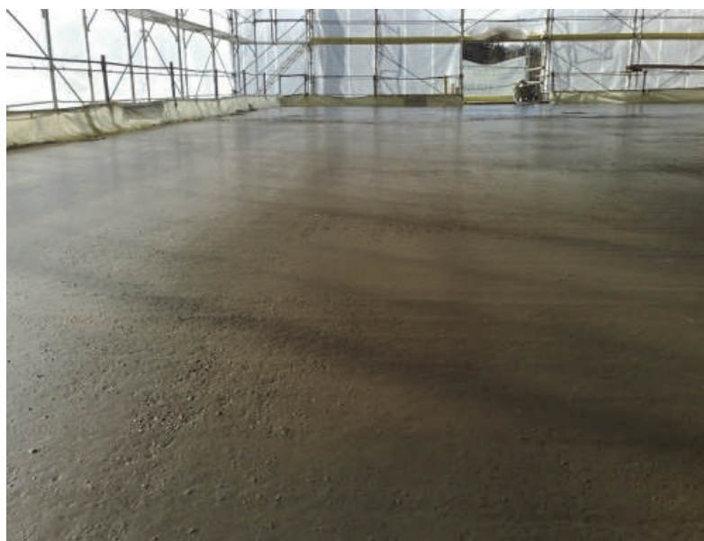
Rys. 3. Widok stropu betonowego badanego budynku kompozytowego – fot. autor
