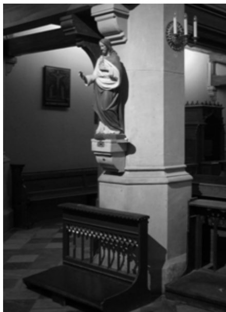
Rys. 4. Oświetlenie figury w kościele pojedynczą oprawą
