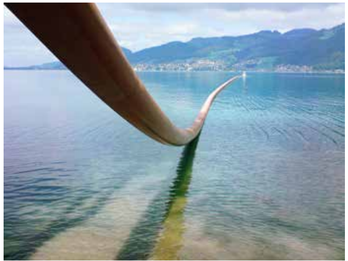
Ryc. 3. Wciąganie rur polipropylenowych w Spiezberg w Szwajcarii, fot. REHAU Sp. z o.o.
