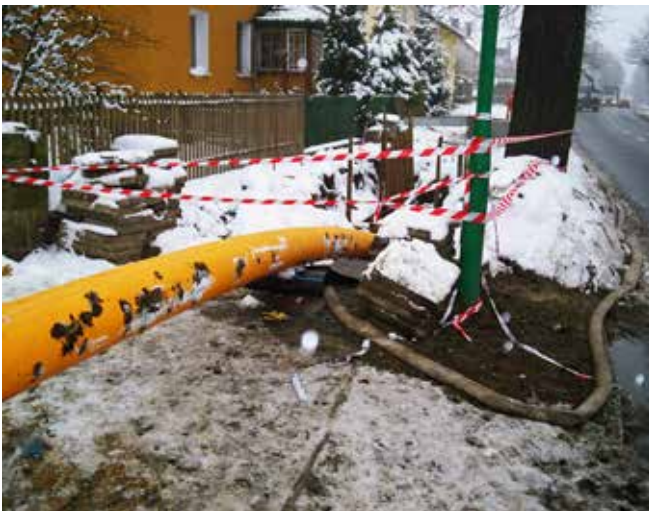
Ryc. 2. Układanie rur polipropylenowych metodą crackingu, fot. ZISBD Wrocław
