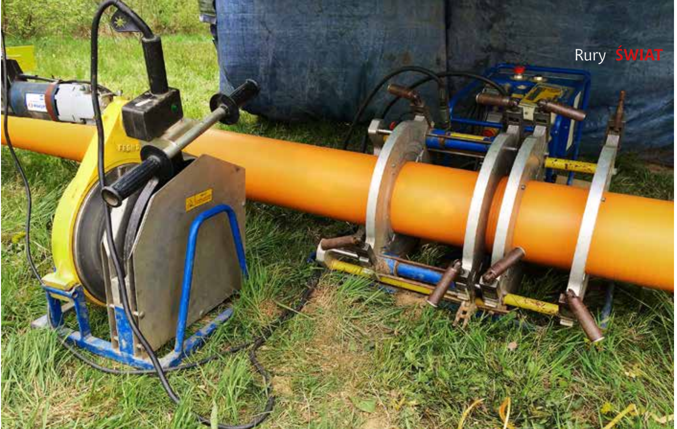
Ryc. 1. Zgrzewanie doczołowe rur polipropylenowych, fot. REHAU Sp. z o.o.
