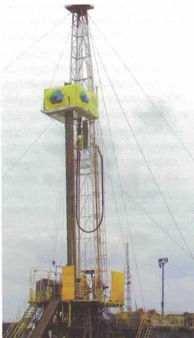
Odwiert wody termalnej finansowany przez NFOŚiGW w Tarnowie Podgórnym (Wielkopolska)
