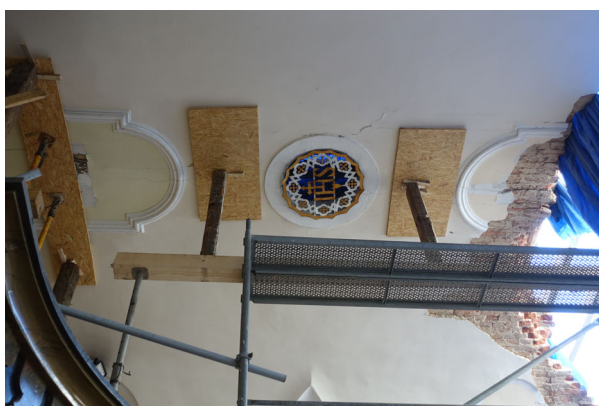
Ryc. 6. Ceglane sklepień kolebkowe podstemplowane elementami historycznej więźby dachowej opartymi na rusztowaniu budowlanym (fot. P. Opałka, 6.06.2018)
