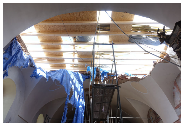
Ryc. 7. Konstrukcja tymczasowego zadaszenia nad nawą główną przed nałożeniem plandek zabezpieczających przed opadami atmosferycznymi (fot. P. Opałka, 22.06.2018)
