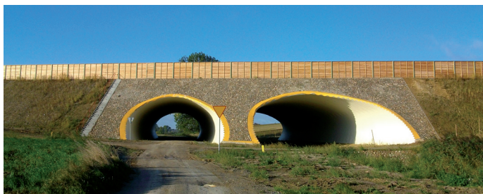
Fot. 5. Obiekty stalowe MS-16a i PG-16b
