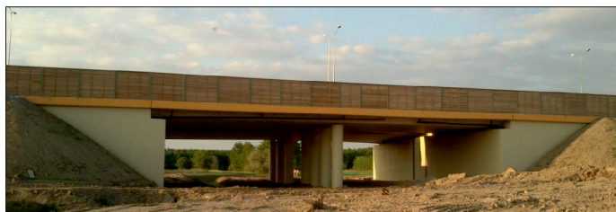
Fot. 3. Obiekt MS-02 – trasa osłonięta ekranami przeciwoślńnieniowymi
