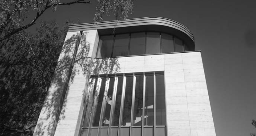
il. 19. Zdjęcie od strony wejścia do budynku przy ulicy Jesionowej 3 (fot. autora) / Photo from the entrance to the building at 3 Jesionowa street (photo by the author)
