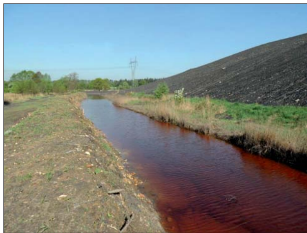
Ryc. 6. Stagnujące wody spływu powierzchniowego w rowie opaskowym. Fot. A. Bauerek
