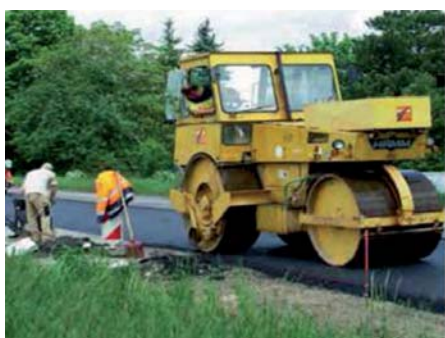
Rys. 10. Zagęszczanie walcem trzykołowym Hamm HV 90
