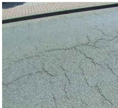
Rys. 2. Widok istniejącej nawierzchni w 2009 r.
