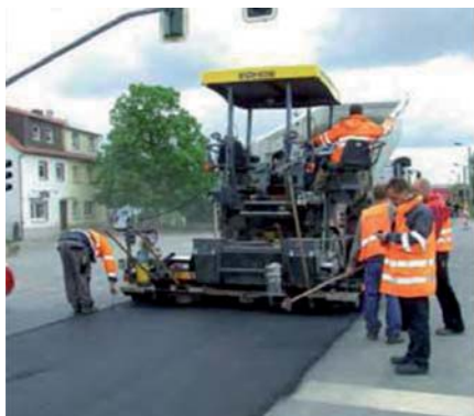
Rys. 8. Rozkładarka firmy Vögele 1303
