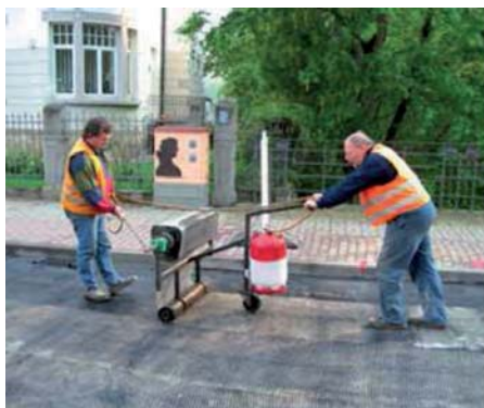
Rys. 3. Rozkładanie zbrojenia
