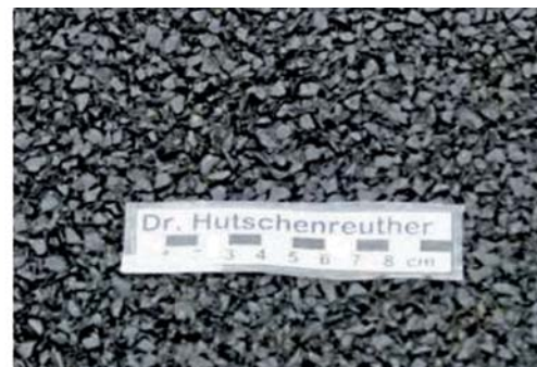
Rys. 21. Widok górnej powierzchni asfalt lanego PMA
