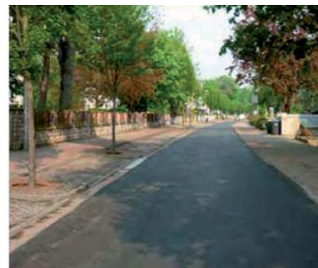
Rys. 5. Widok wykonanej nawierzchni – maj 2011 r.
