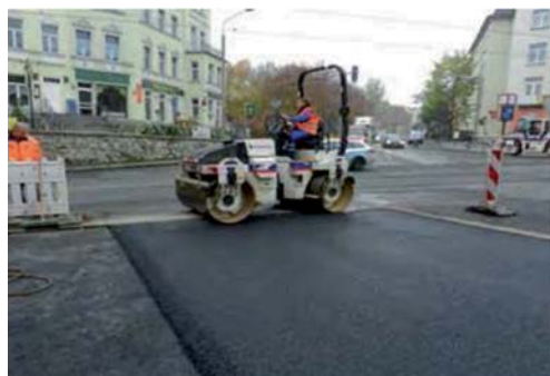
Rys. 20. Przejazd lekkim walcem statycznym
