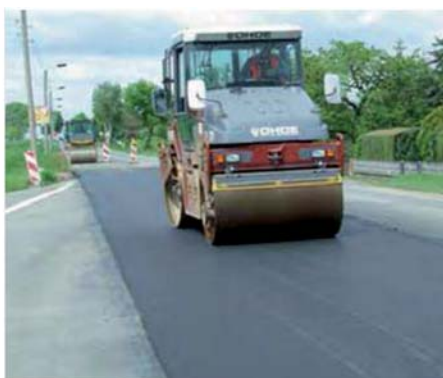
Rys. 9. Walec tandemowy Hamm DV 70
