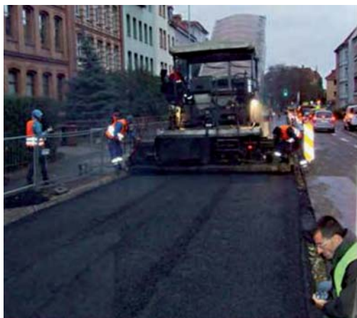
Rys. 16. Porowaty asfalt lany PMA 5 – odcinek próbny
