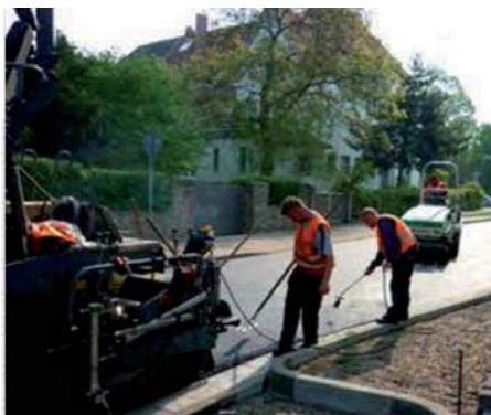
Rys. 4. Wbudowanie SMA 8S
