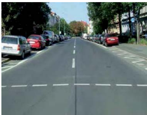
Rys. 23. Wykonany odcinek w ciągu ulicy Moritzwallstraße – stan w miesiącu wrześniu 2012 r.
