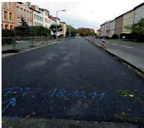
Rys. 17. Odcinek próbny – północny fragment wykonanej nawierzchni
