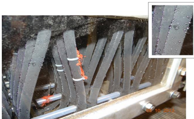
Rys. 7: Proces kondensacji pary wodnej w spalinach obserwowany w okienku inspekcyjnym
