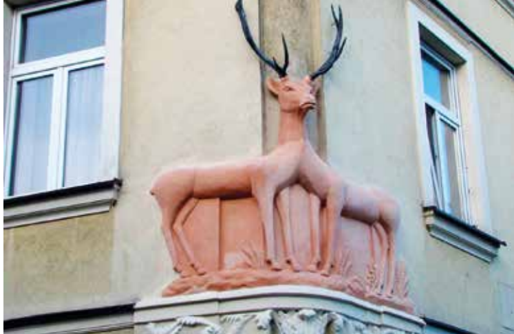
Dworek Pod Jeleniem, Kraków, Rynek Podgórski 12. Płaskorzeźba wykonana z cementu romańskiego wyprodukowanego w ICiMB – Oddział w Krakowie (Źródło: Archiwum ICiMB)
