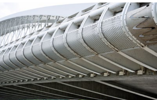
Balustrada mostu Trojskiego
