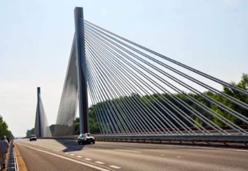
Pylony obiektu nr 56 widziane z jezdni mostu
