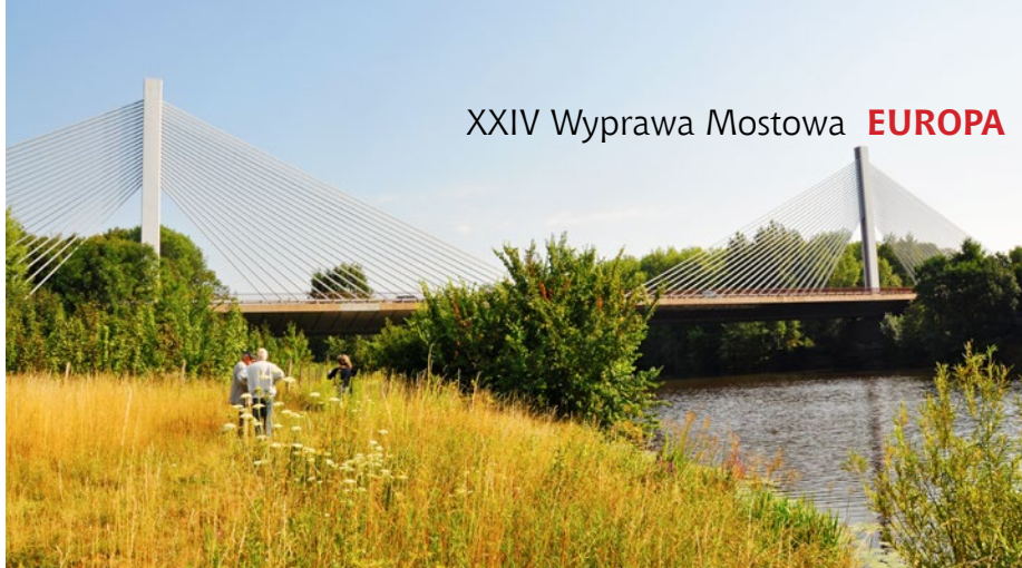
Dwupylonowy, podwieszony most betonowy przez Łabę w Podiebradach (obiekt nr 56)
