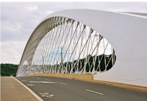
Jezdnia i olinowanie podwieszonych pomostu w moście Trojskim
