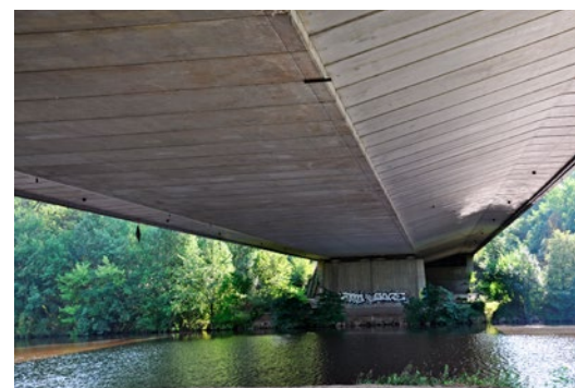
Dwupylonowy, podwieszony most betonowy przez Łabę w Poděbradach (obiekt nr 56)
