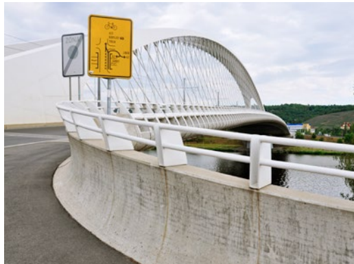
Betonowa balustrada jezdni prowadzącej na most Trojski
