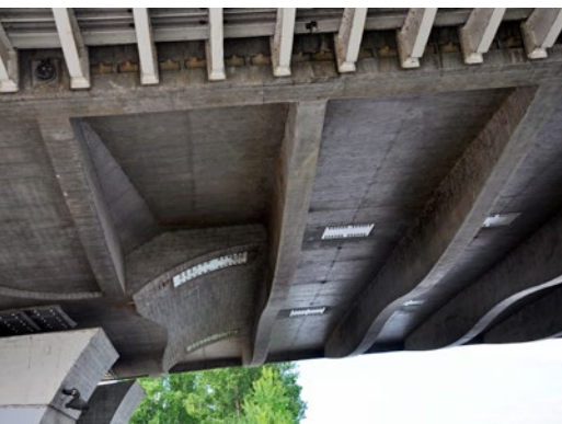
Strefa podporowa mostu Trojskiego
