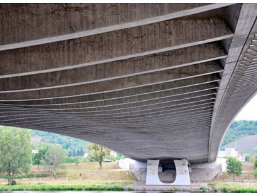
Poprzecznicę pomostu mostu Trojskiego
