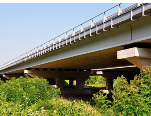
Betonowy, belkowy most dojazdowy do obiektu nr 56 (obiekt nr 57)
