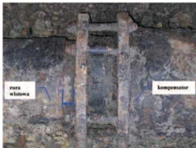
Fot. 4. Ślady rozsunięcia kompensatora gazociągu DN200
