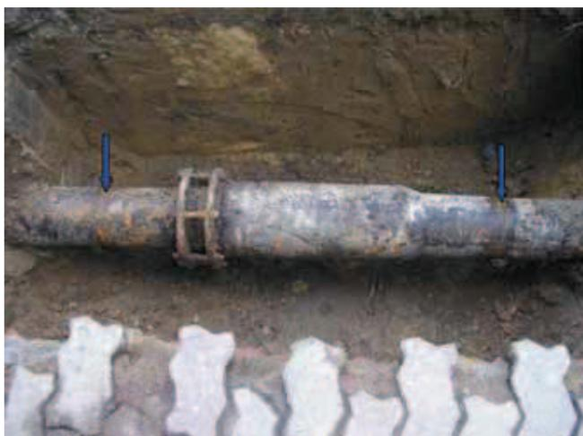
Fot. 2. Kompensator w gazociągu stalowym niskiego ciśnienia DN200, złącza rur spawane
