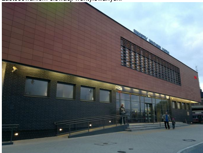
Fot.1. Elewacja budynku dworca kolejowego w Lesznie (źródło: https://pl.wikipedia.org , zdjęcie autorstwa Lucaok)
