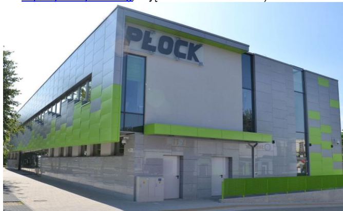
Fot.2. Elewacja budynku dworca kolejowego w Płocku (źródło: https://pl.wikipedia.org , zdjęcie autorstwa Lichen99)
