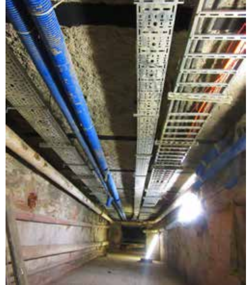
Strop nad korytarzem piwnicy po naprawie
