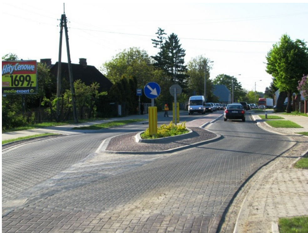
Fot. 1. Brama wjazdowa na drodze wojewódzkiej nr 824 w Puławach.
