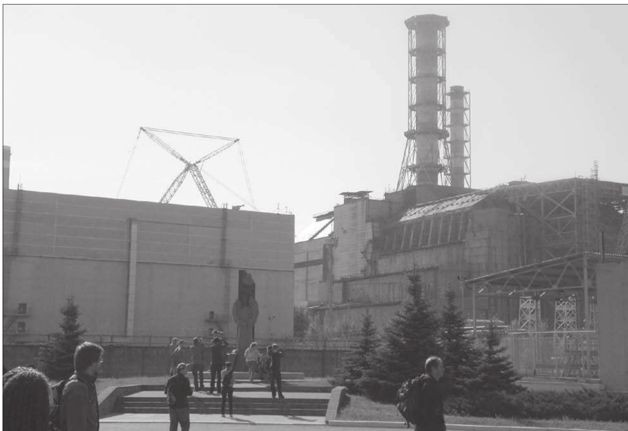
Fot. 4. Sarkofag nad zniszczonym blokiem nr 4
