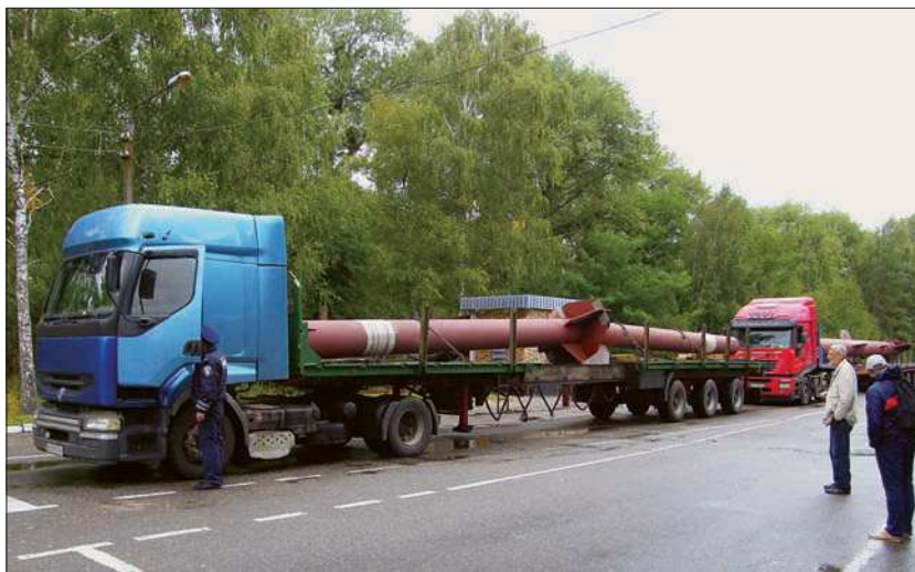
Fot. 1. Transport elementów do budowy Arkady (nowego sarkofagu)
