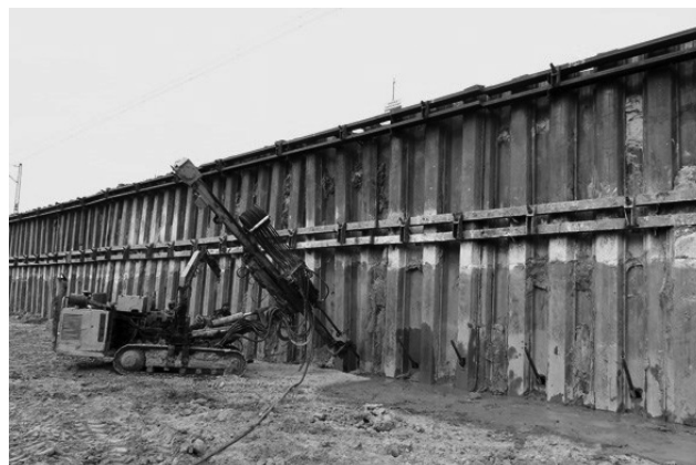
Rys. 9. Ścianka szczelna kotwiona [31]
