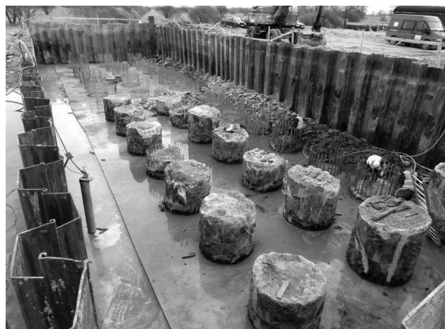
Rys. 5. Widok ścianki szczelnej w złożonych warunkach wodno-gruntowych [32]
