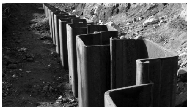
Rys. 8. Wykonana ścianka szczelna wspornikowa – widok od góry [30]
