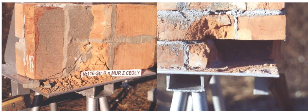
Fot. 1. Efekty trafienia pocisku w mur ceglany [4]
