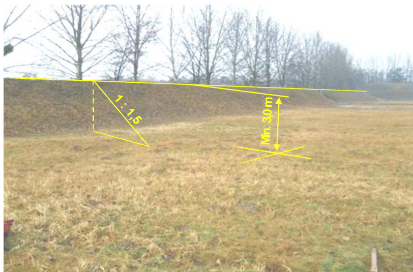
Rys. 16. Geometria zabezpieczenia bocznego strzelnicy
