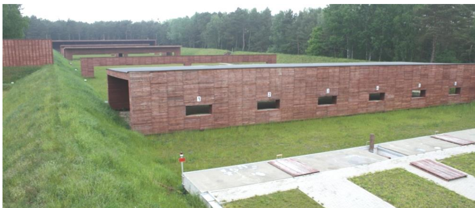
Fot. 6. Widok zabudowy strefy strzelań strzelnicy „200 m” w I klasie bezpieczeństwa (9 przesłon pionowych, zabudowa kulochwytu głównego oraz zabezpieczenia boczne)
