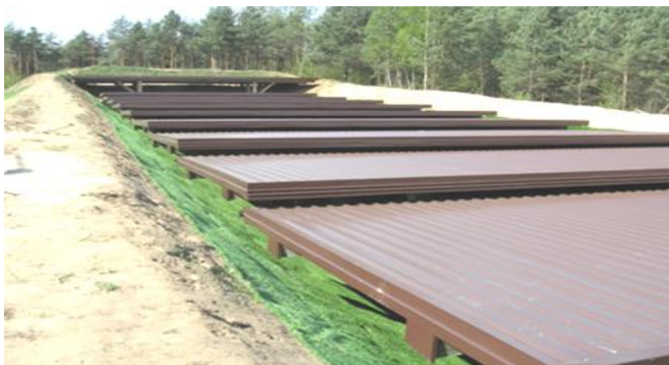
Fot. 7. Sposób zabezpieczenia górnej strefy strzelań przesłonami ukośnymi
