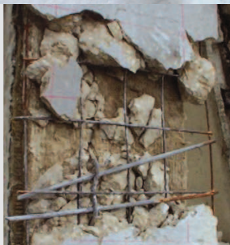
Rys. 13. Przykłady wadliwego zamontowania wieszaków dwugarbnych [fot. Inwstbud]
