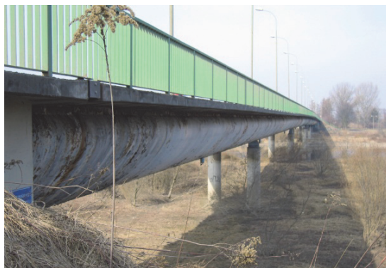
Rys. 1. Widok konstrukcji mostu od strony dolnej wody
