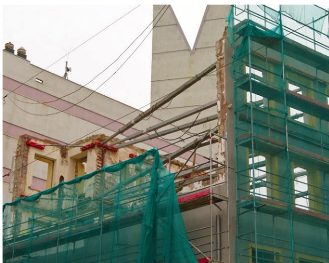
Rys. 4. Częściowo zrealizowane prace związane ze stężeniem ścian zewnętrznych od strony ulicy Szewskiej (zdjęcie autorów)
