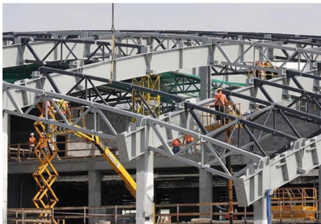
Rys. 11. Konstrukcja stalowa dachu terminala lotniczego w Rzeszowie-Jasionce
