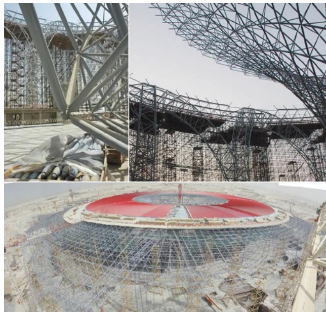
Rys. 17. Widok stalowej konstrukcji prętowej Ferrari World Abu Dhabi (źródło: www.mero.de)
