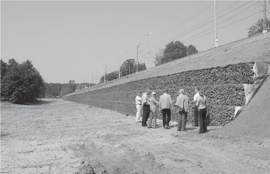
Rys. 8. Dokumentacja fotograficzna obudowy uszkodzonego nasypu {6}
