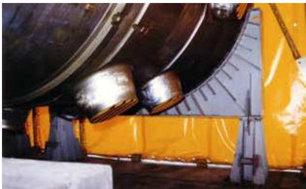
Fot. 4. Zbiornik ciśnieniowy reaktora 1-bloku magazynowany w tymczasowym namiocie na placu budowy EJ „Żarnowiec” (fot. W. Kiełbasa)
